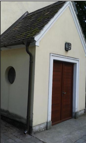
Am Vorbau zum Kircheneingang wurden von der Fa. Bolkovac neue Dachrinnen und Ablaufrohre montiert. Durch diese Maßnahme soll der Feuchtigkeit im Mauerwerk, hervorgerufen durch Spritzwasser, entgegengewirkt werden. Weiters wurde im Eingangsbereich der Kirche und in der Sakristei je ein Feuerlöscher montiert. Im Ernstfall stehen somit geeignete Hilfsmittel zur Brandbekämpfung zur Verfügung.
