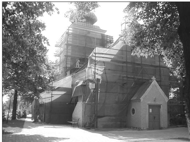
Kugel und Turm repariert. Die Steineinfassungen bei Fenster und Türen werden mechanisch abgeschabt und mit Wirbelstrahlgerät gereinigt.
